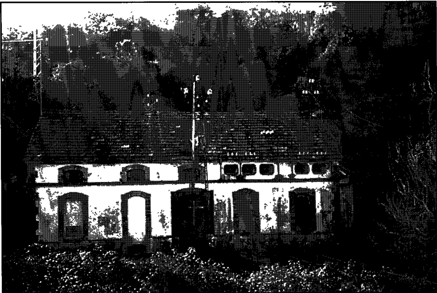
Central Hidroeléctrica de “Los Batanes” popularmente conocida como “El Salto”
