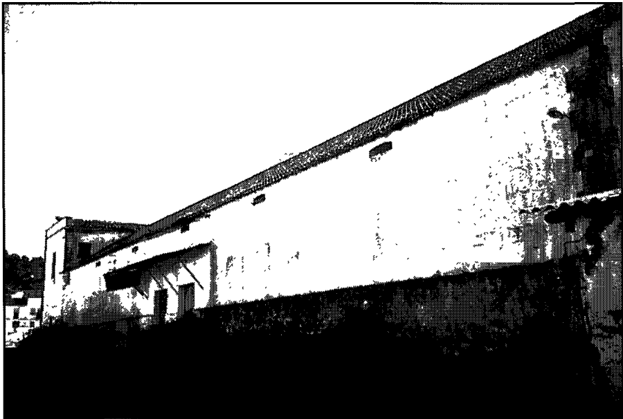
Almacén de harinas de Santa Teresa en El Repilado
