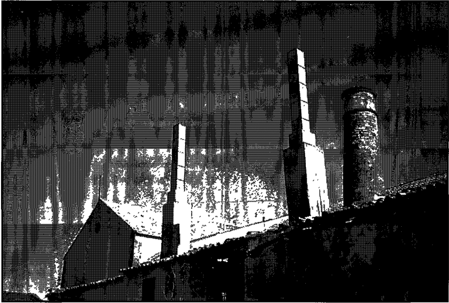
Chimeneas de los hornos de la panadería. El Repilado.
