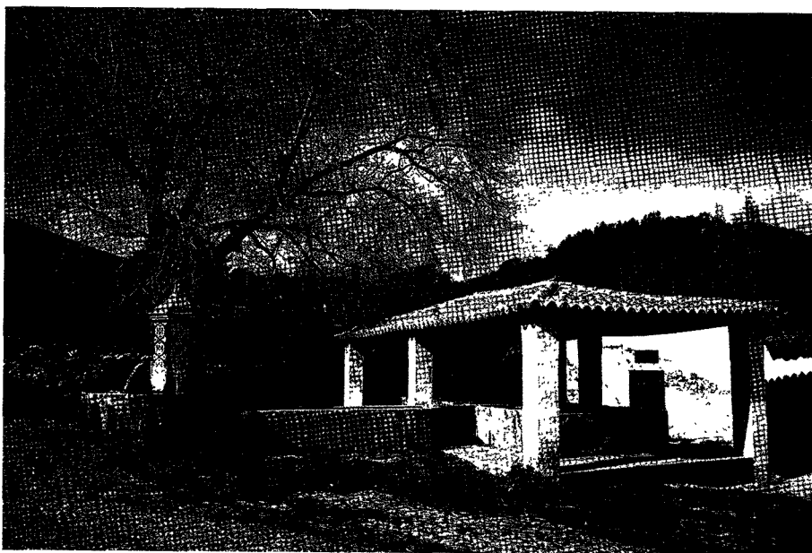
Lavadero del municipio de Santa Ana la Real.
