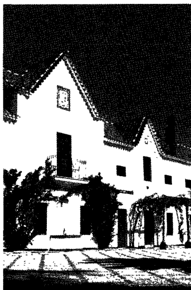
Figura 7. Finca Monte S. Miguel (1907-12 y 1924). Edificio principal de servicio. CN-433, Km 87
