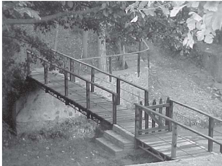
Puente con accesos que salva la ribera.
