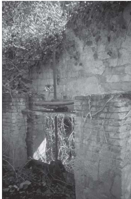
Volantes de la presa durante su restauración
