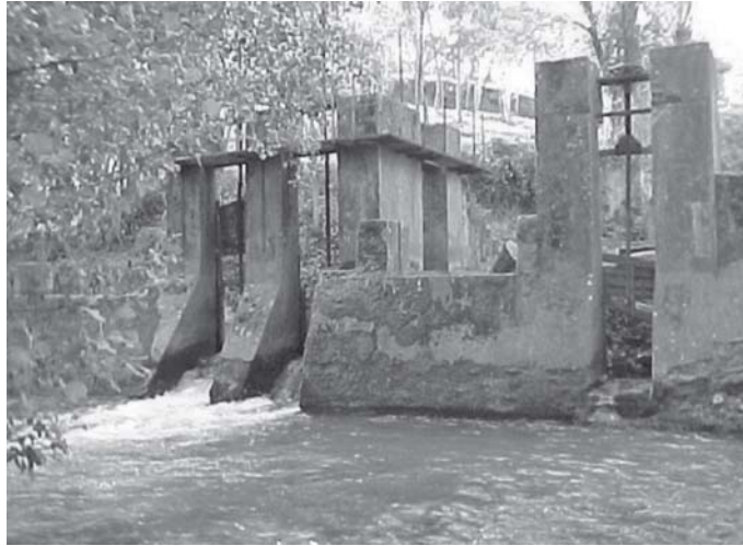
Presas libre de maleza y presta a ser rehabilitada
