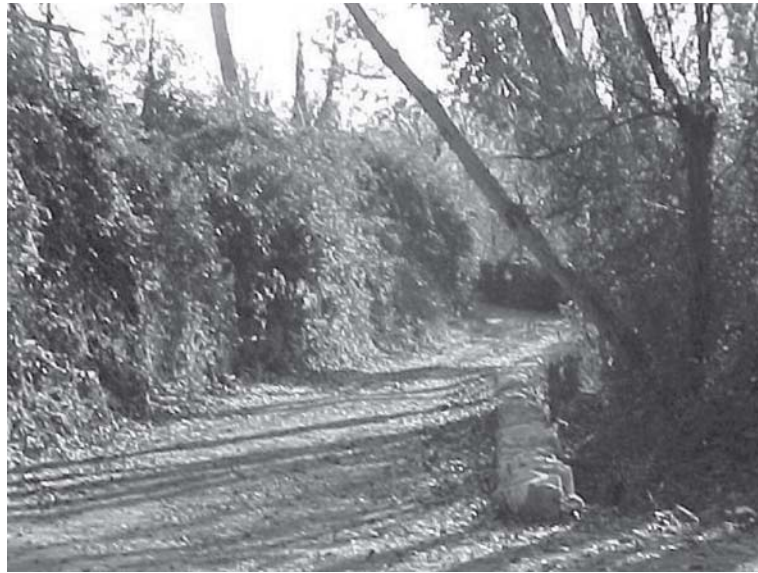
Camino Real Jabugo-Las Chinas tras su recuperación
