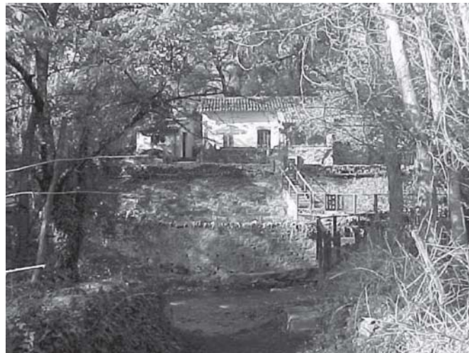
Casa del Guardalievias, en la actualidad. Pueden distinguirse el camino Jabugo-Las Chinas, en primer término, el puente de acceso a la otra orilla y la ribera con su bosque de galería característico.
