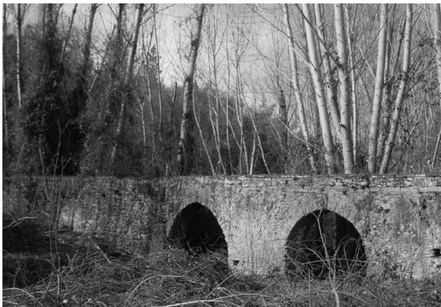
Estado final del acueducto tras los trabajos de limpieza de Lieva
