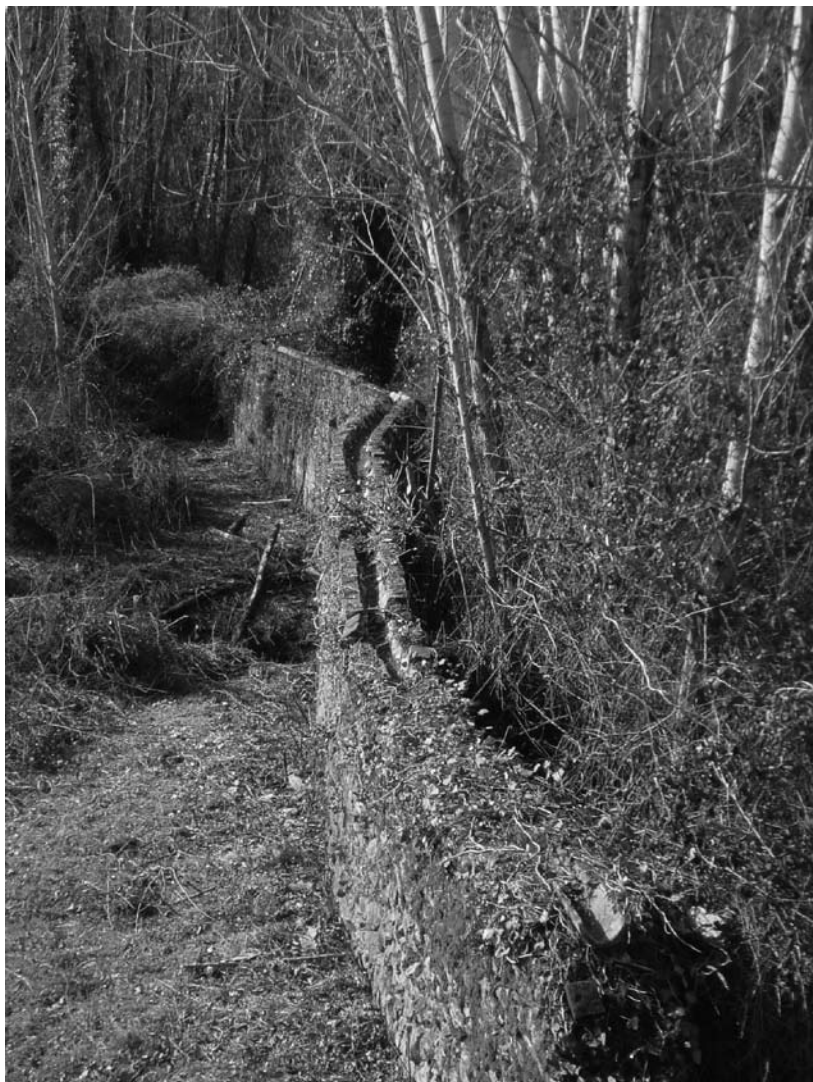
Parte superior del Acueducto en la que se aprecia la lieva que conducía el agua
