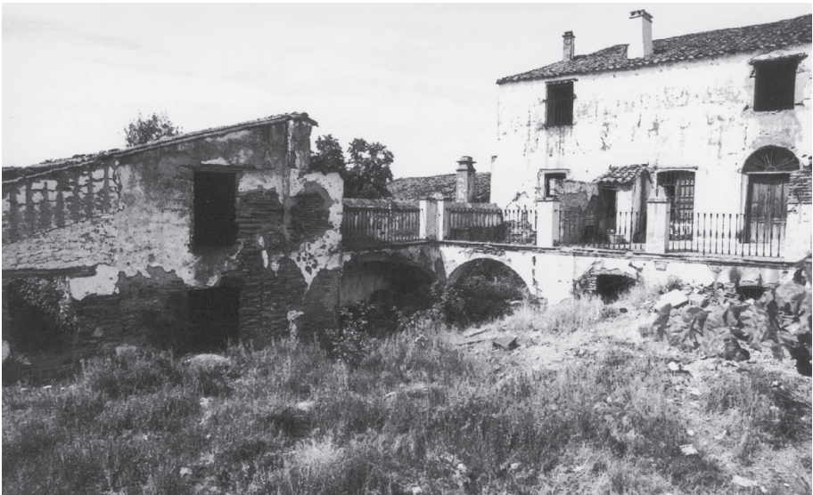
Desde el patio de la 20689-05 antes de su reforma para Casa de la Cultura.
