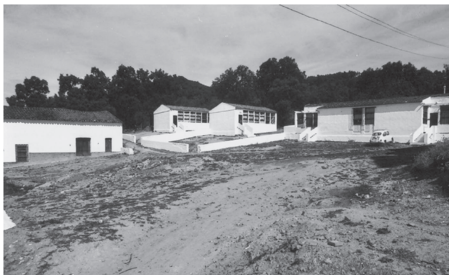
Escuelas y casas de maestros, ambas derribadas para el nuevo edificio de escuelas y el centro de la juventud respectivamente.
