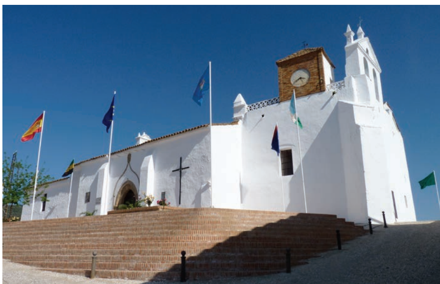
Fig. 2.- Iglesia parroquial de Hinojales. Vista general desde el sureste.
