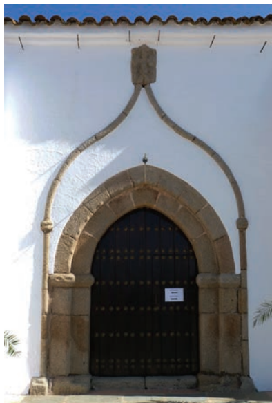
Fig. 7.- Iglesia parroquial de Hinojales. Puerta lateral (fachada meridional).
