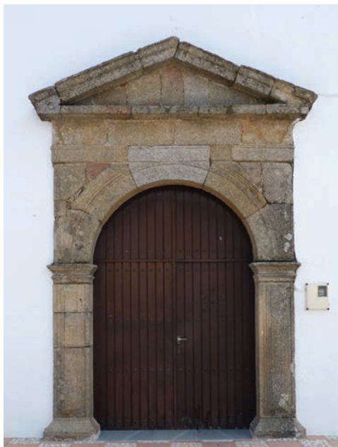
Fig. 8.- Iglesia parroquial de Hinojales. Puerta de la fachada occidental.
