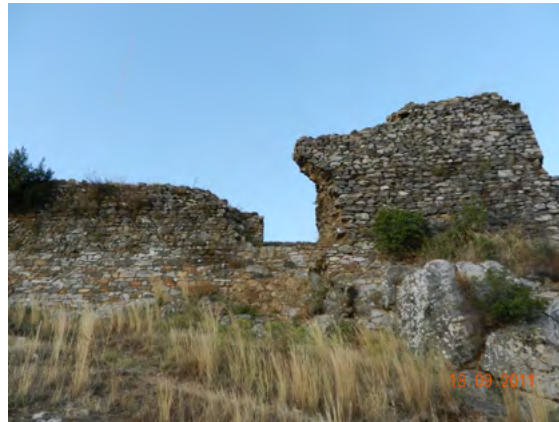
Fig. 15-16-17. - Secuencia de restauración de la fachada su r y poterna del Alcázar. (Fot. I. Jiménez Aguilar).
