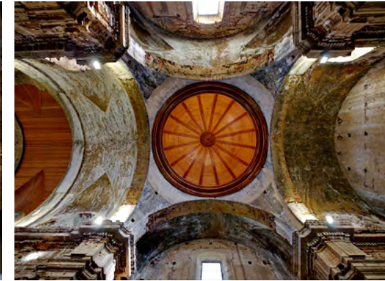
Vista de los techos tras la restauración, con la cúpula de media naranja de madera: (Foto: GDB).
