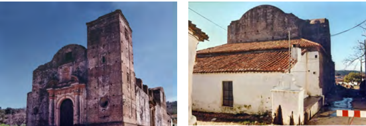
La Iglesia Inacabada en 1991. Muro de los pies con la torre sin cuerpo de campanas y muro de la cabecera con una construcción adosada a la sacristía. (Fotos: ANFV).
