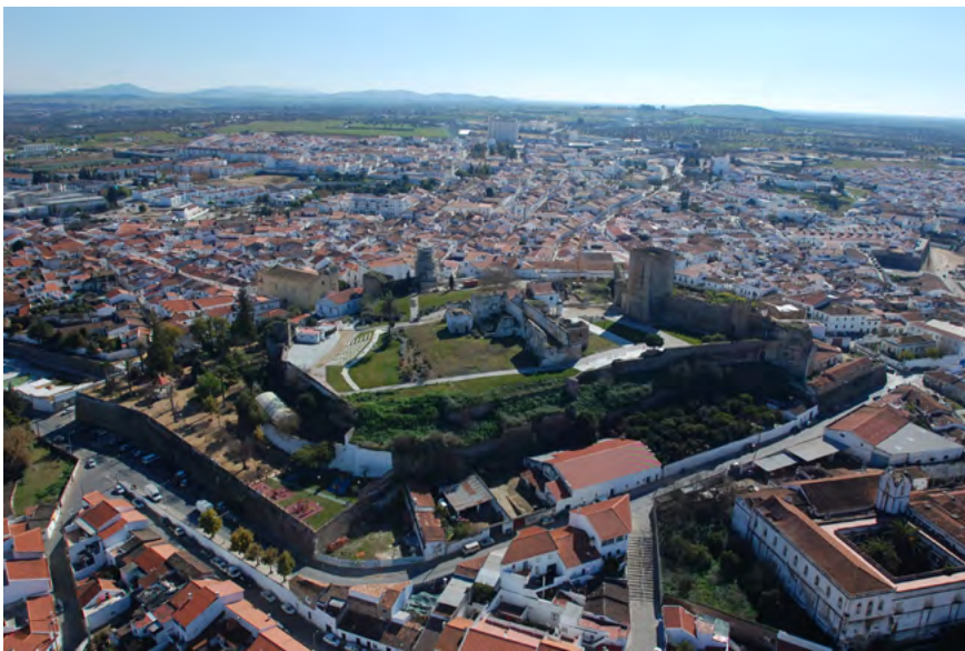
Imagen aérea recinto fortificado de Serpa.
