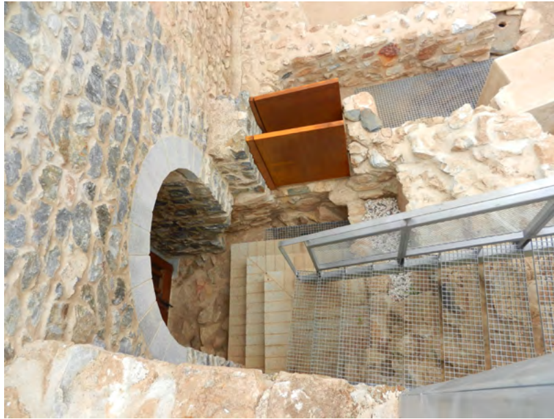
Fig. 13-14. - Amortización de fábricas. Puesta en valor de la escalera y área interior de la poterna. (I. Jiménez).
