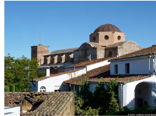
Vista de la Iglesia Inacabada tras la restauración de los años noventa. (Foto GDB)
