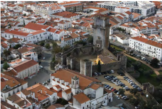
Imagen aérea recinto fortificado de Beja.
