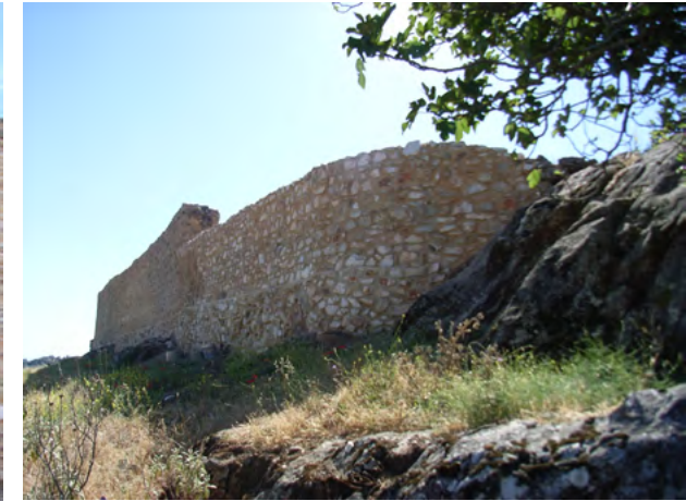
Fig. 3. Estado final, tras la consolidación estructural realizada en 2008. (Fot. I. Jiménez Aguilar)
