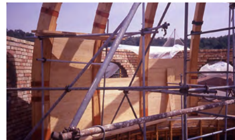
Diversos momentos del proceso constructivo con madera de la cúpula y los tramos de bóveda. (Fotos: ANFV).
