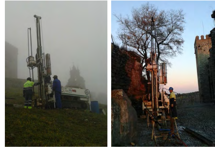
Fig.5. Imágenes del equipo de perforación Rolatec RL 48-M utilizado en las dos perforaciones realizadas en el Cerro del Castillo (izquierda, sondeo 1 y derecha, sondeo2). Fotografías: W. Martín.
