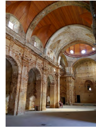
Interior tras la restauración, con los dos tramos de bóveda y la cúpula ejecutados en madera. (Foto: GDB).
