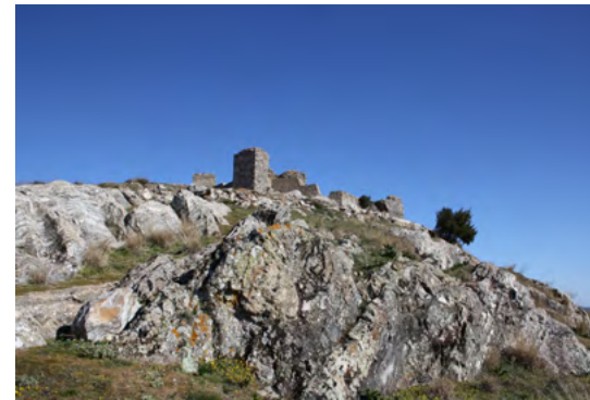
Figura 2. Imagen del recinto fortificado de Aracena antes de su restauración en 2014.
