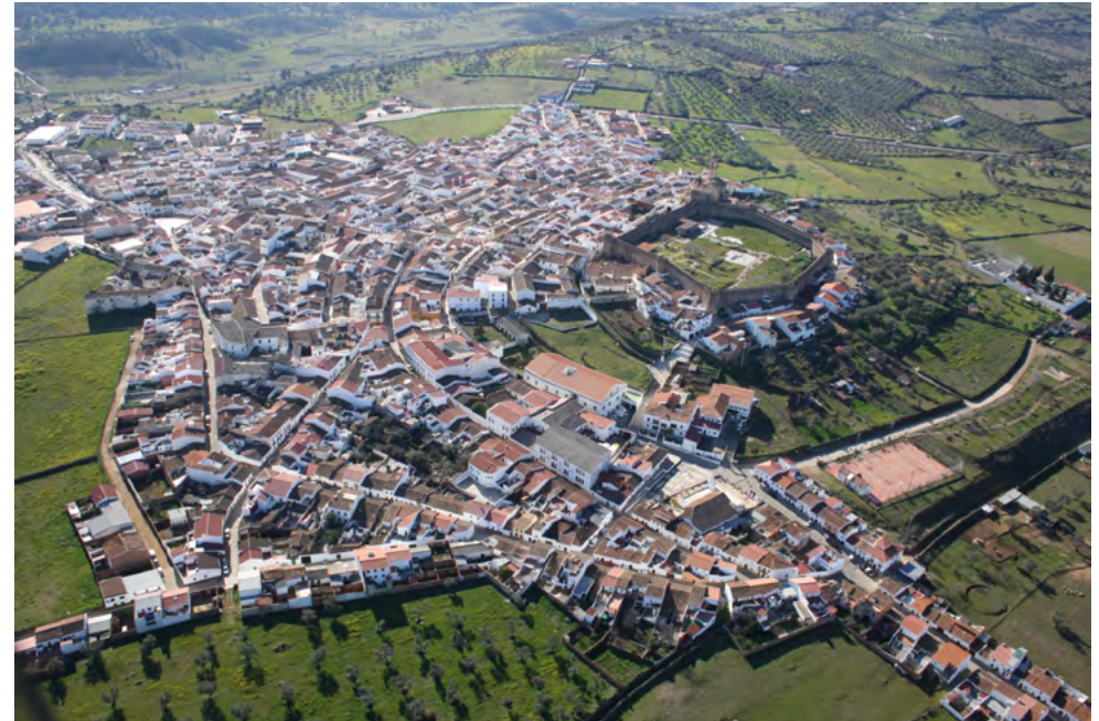
Imagen aérea recinto fortificado de Aroche.
