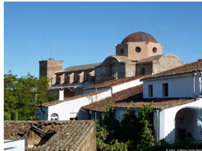
Vista de la Iglesia Inacabada tras la restauración de los años noventa. (Fotos GDB).
