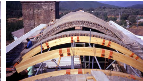
Diversos momentos del proceso constructivo con madera de la cúpula y los tramos de bóveda. (Fotos: ANFV).
