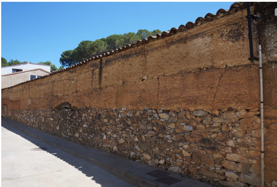
Fig. 5. Muro de tapial en C/Taladores de Galaroza. Elaboración propia.
